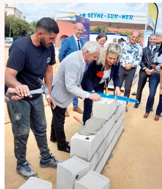
Pose de la première pierre sur le chantier de l'IME Léo LAGRANGE
