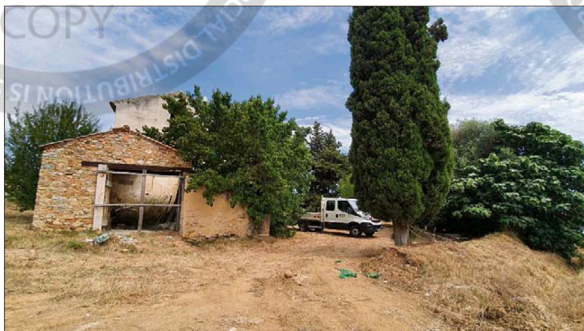
Les travaux sur le site de Mauvéou ont commencé mercredi dernier.
